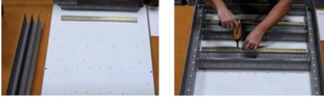
Görsel 1.12: Kanalların ve rayların montajı
